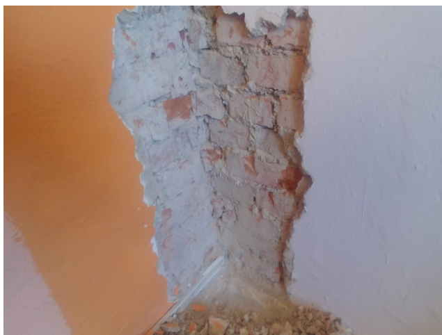
foto/25/ Pohled na provázání příčky s vnitřní nosnou stěnou
