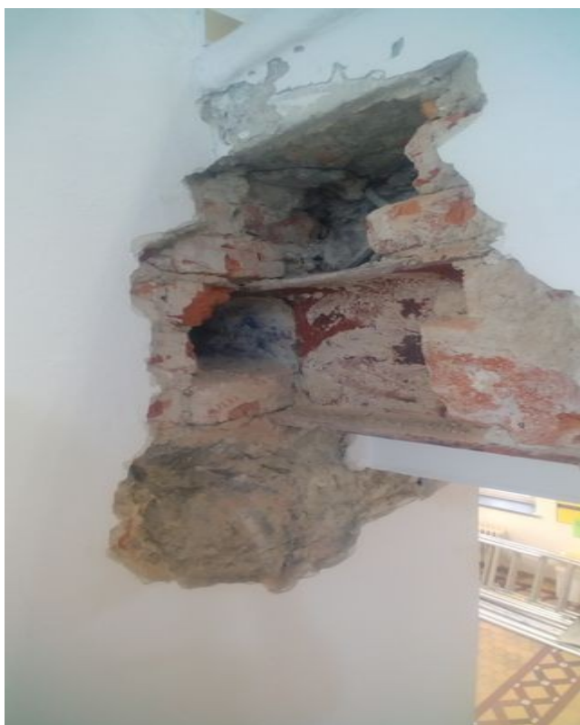
foto/32/ Pohled na uložení průvlaku ve stěně
