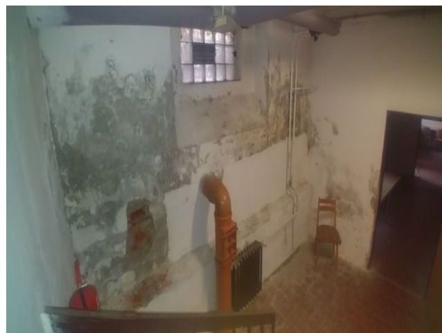
foto/29/ Pohled na projevy vlhkosti ve stejném místě ze strany interiéru
