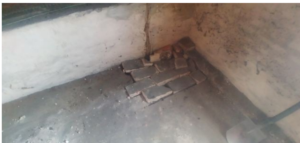
foto/20/ Pohled na zapravení provedené sondy P7
