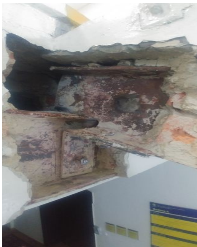
foto/33/ Pohled na napojení schodnice na průvlak
