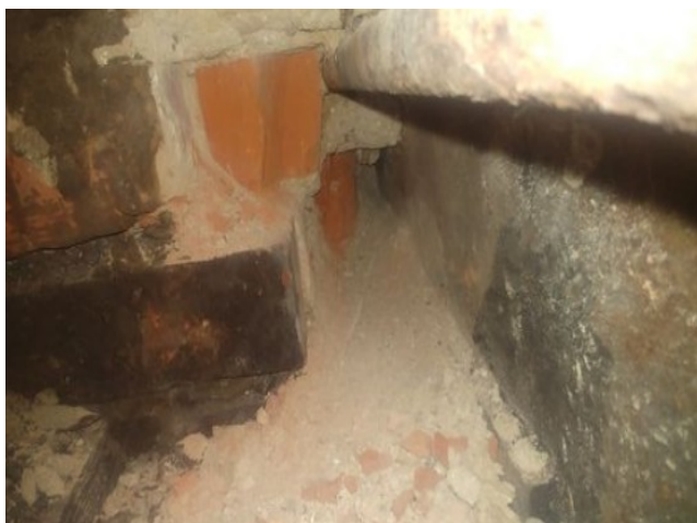
foto/26/ Pohled na uložení válcovaného profilu na vnitřní stěnu
