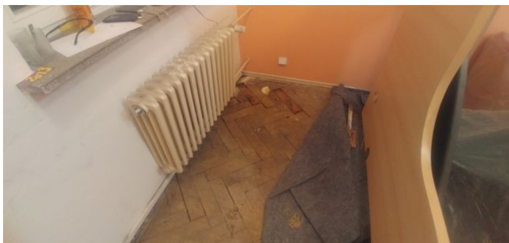
foto/16/ Pohled na zapravení provedené sondy P5
