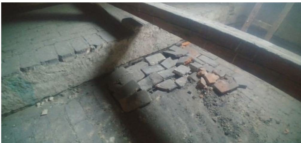
foto/22/ Pohled na zapravení provedené sondy P8
