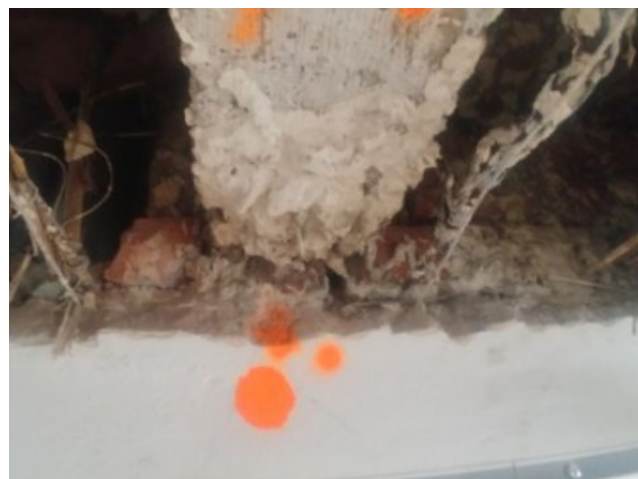
foto/27/ Pohled na uložení železobetonového stropu na vnitřní stěnu
