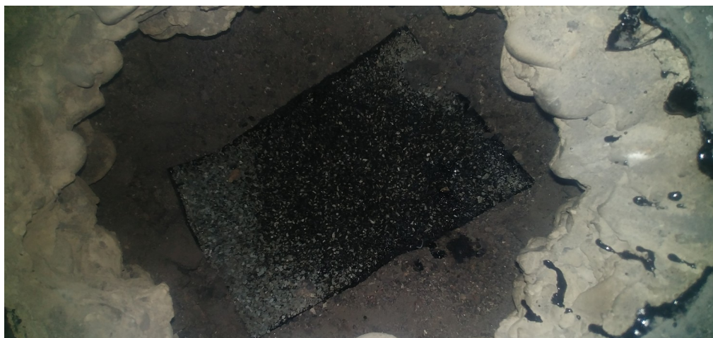
foto/7/ Pohled na zapravení hydroizolace v místě sondy P2
