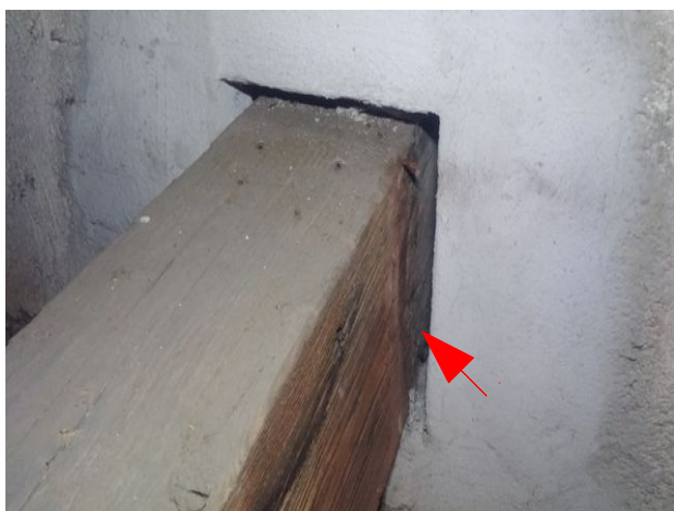
obr /14/ Pohled na místo odběru vzorku S13 - zhlaví vazného trámu
