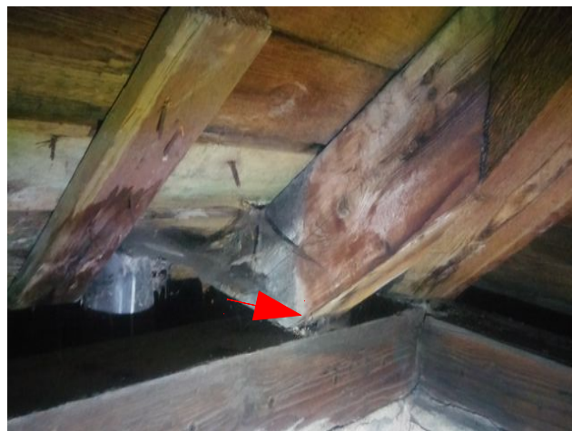
obr /3/ Pohled na místo odběru vzorku S2 - pata krokve
