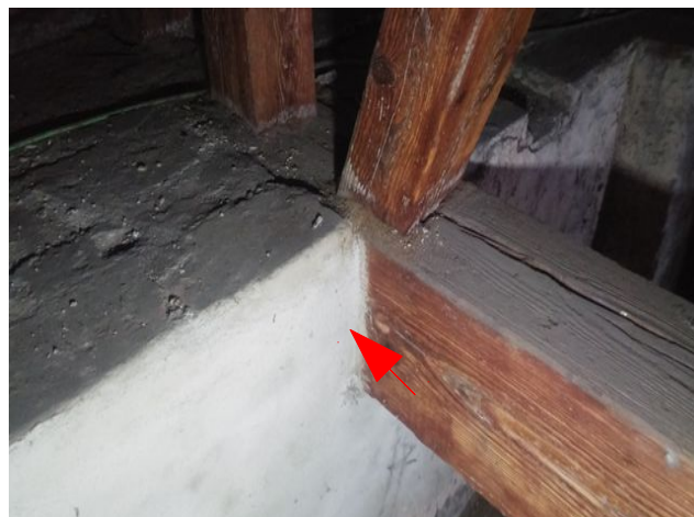
obr /7/ Pohled na místo odběru vzorku S6 - zhlaví vazného trámu
