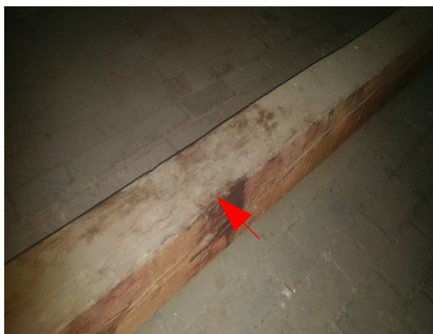
obr /4/ Pohled na místo odběru vzorku S3 – vazný trám
