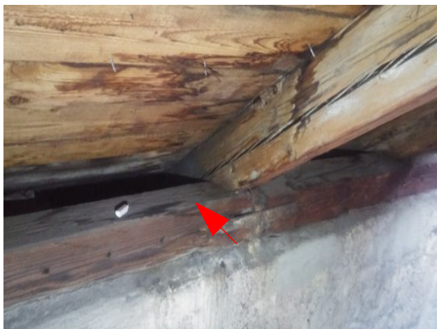
obr /2/ Pohled na místo odběru vzorku S1 – pozednice
