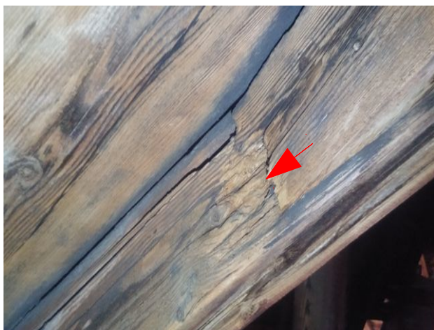
obr /10/ Pohled na místo odběru vzorku S9 - styk sloupku a pásku
