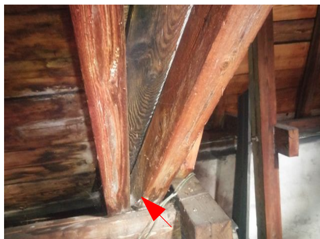
obr /15/ Pohled na místo odběru vzorku S14 - úžlabní krokve
