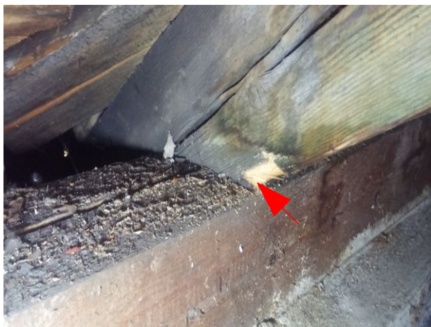
obr /12/ Pohled na místo odběru vzorku S11 - pata krokve
