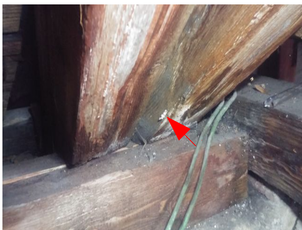
obr /16/ Pohled na místo odběru vzorku S15 - úžlabní krokve
