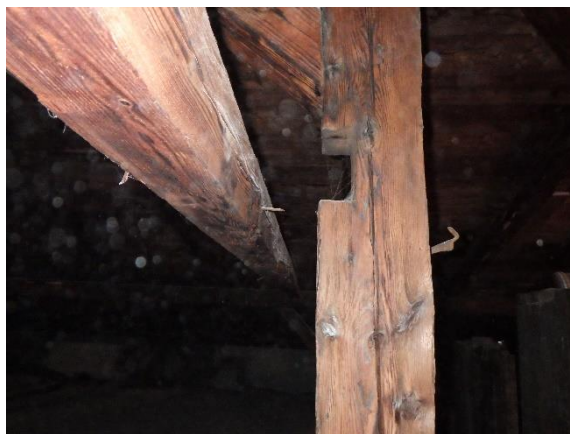
Foto č. 72-75 – Krov- detaily prvků- vyjetí ze spoje, napadení dřevokaznými činiteli a osazení z hlavi vazného trámu do vzduchové kapsy;
