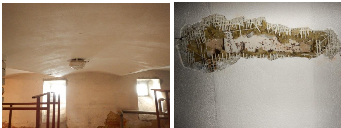
Foto č. 23;24 - sonda NV29-celkový pohled, detail použití zateplení – minerální vatou;
