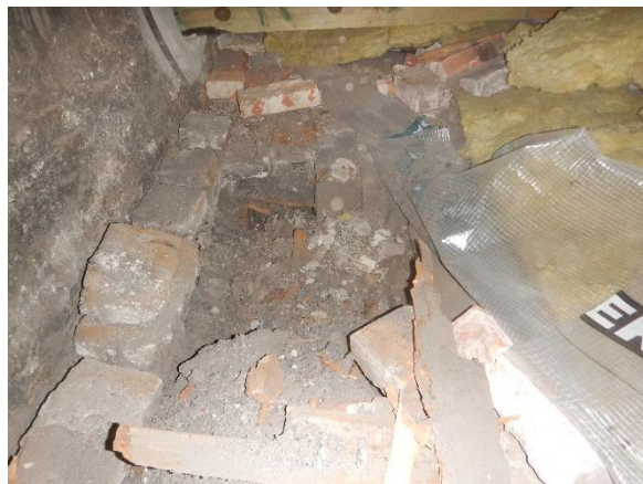
Foto č. 55 – NV38-celkový pohled na sondu;
