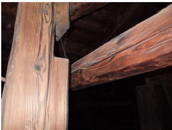
Foto č. 72-75 – Krov- detaily prvků- vyjetí ze spoje, napadení dřevokaznými činiteli a osazení z hlavi vazného trámu do vzduchové kapsy;
