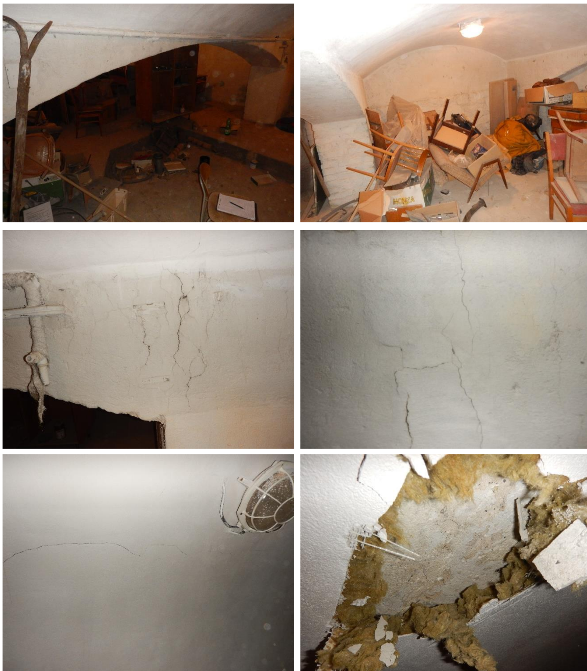
Foto č. 23;24 - sonda NV29-celkový pohled, detail použití zateplení – minerální vatou;
