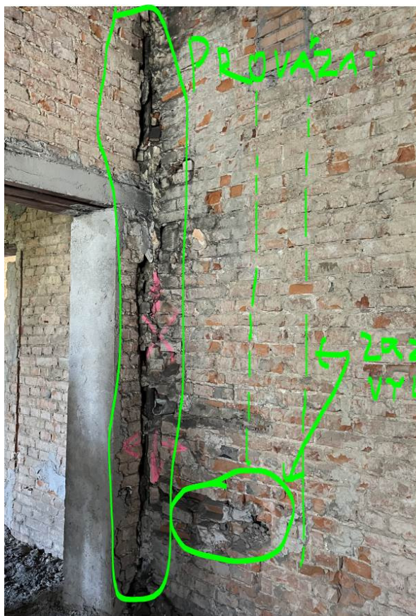
Spoj mezi zdmi provázat, kominové těleso s dutinami vylít zálivkou
