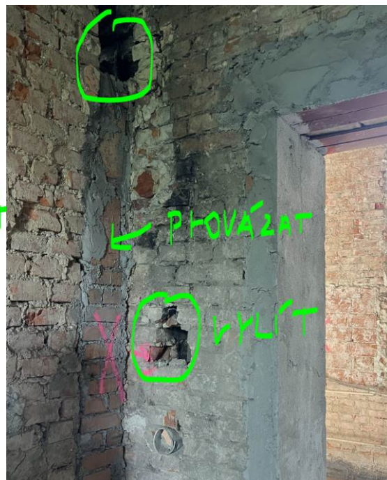
Spoj mezi zdmi provázat, kominové těleso s dutinami vylít zálivkou
