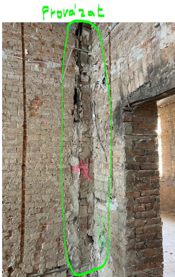
V rohu provázat zdivo plnými cihlami na cementovou maltu
