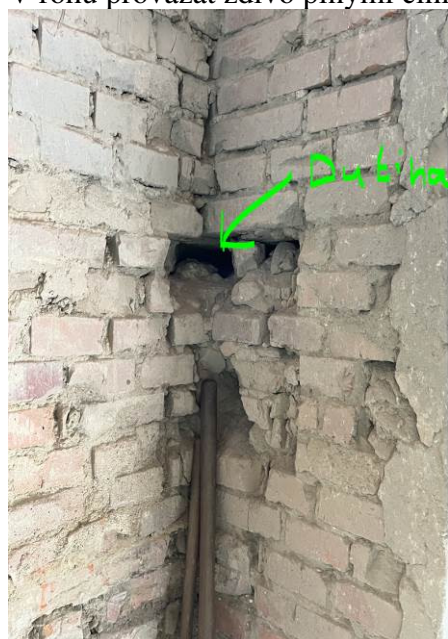
V rohu provázat zdivo plnými cihlami na cementovou maltu
