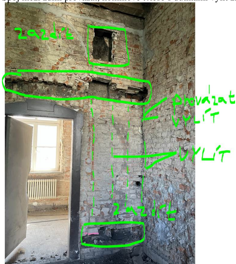
Spoj mezi zdmi provázat, kominové těleso s dutinami vylít zálivkou
