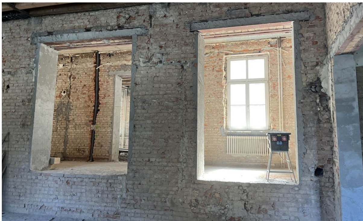
Pilíře v 1NP pro vylití dutin a obandážování.
