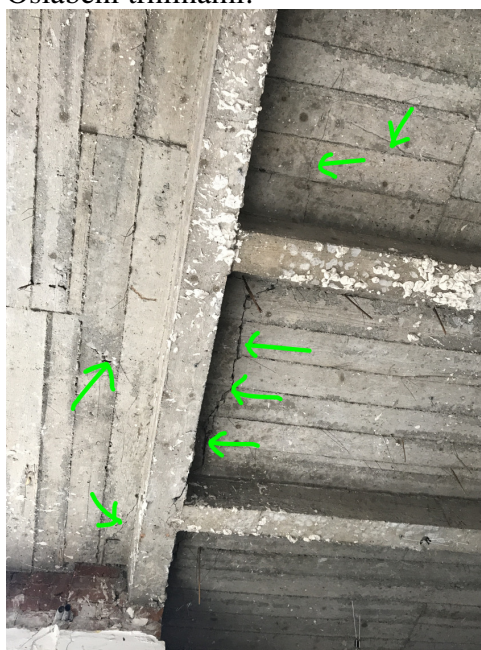
Oslabení trhlinami:
