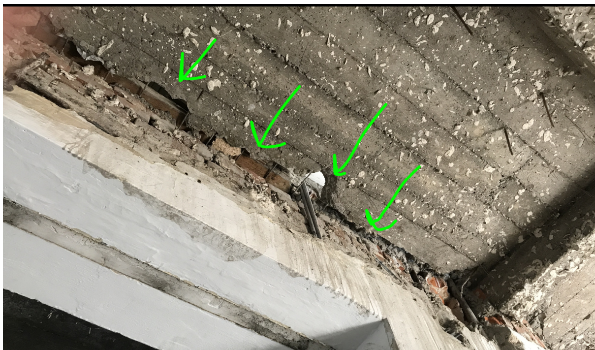
Oslabení trhlinami:
